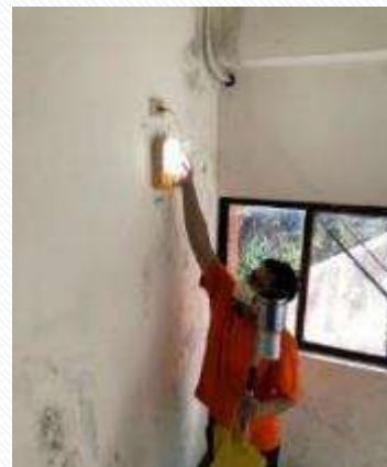
緊急照明燈具
