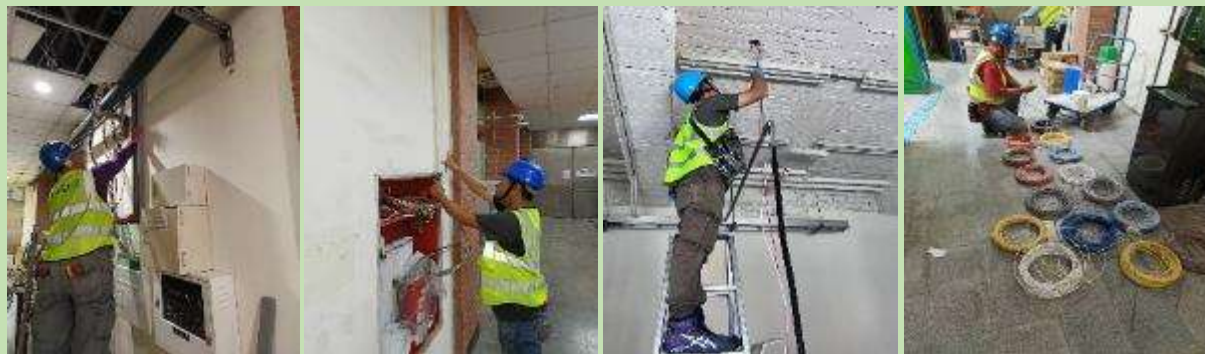
更新總機、老舊探測器及線路抽換
