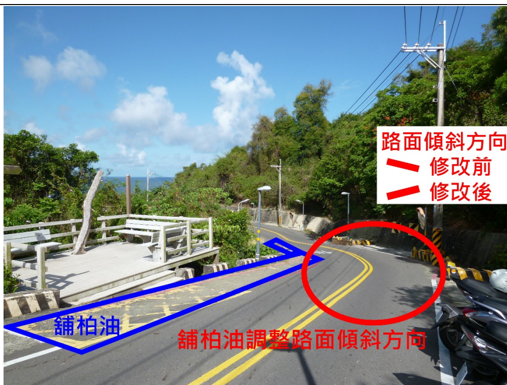
3. 鋪設柏油及調整路面傾斜方向。
