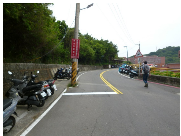
劃設停止線照片
