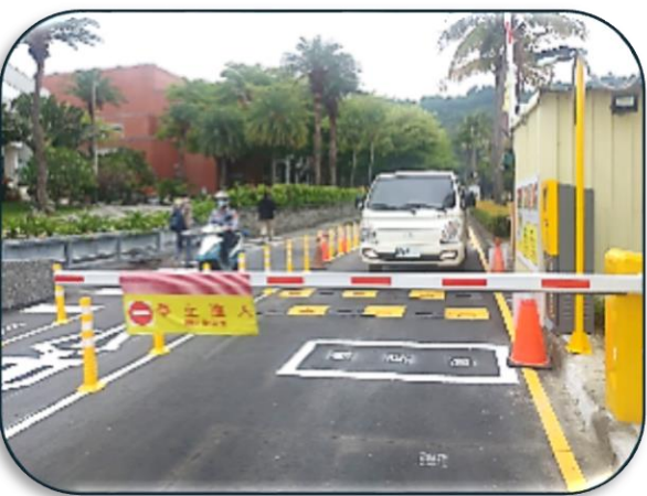
海堤入口人車分道
