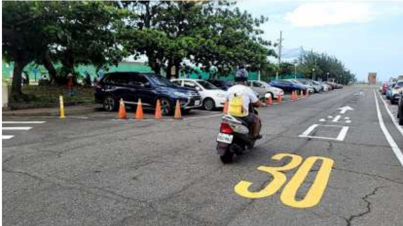
海堤停車場-施工前
