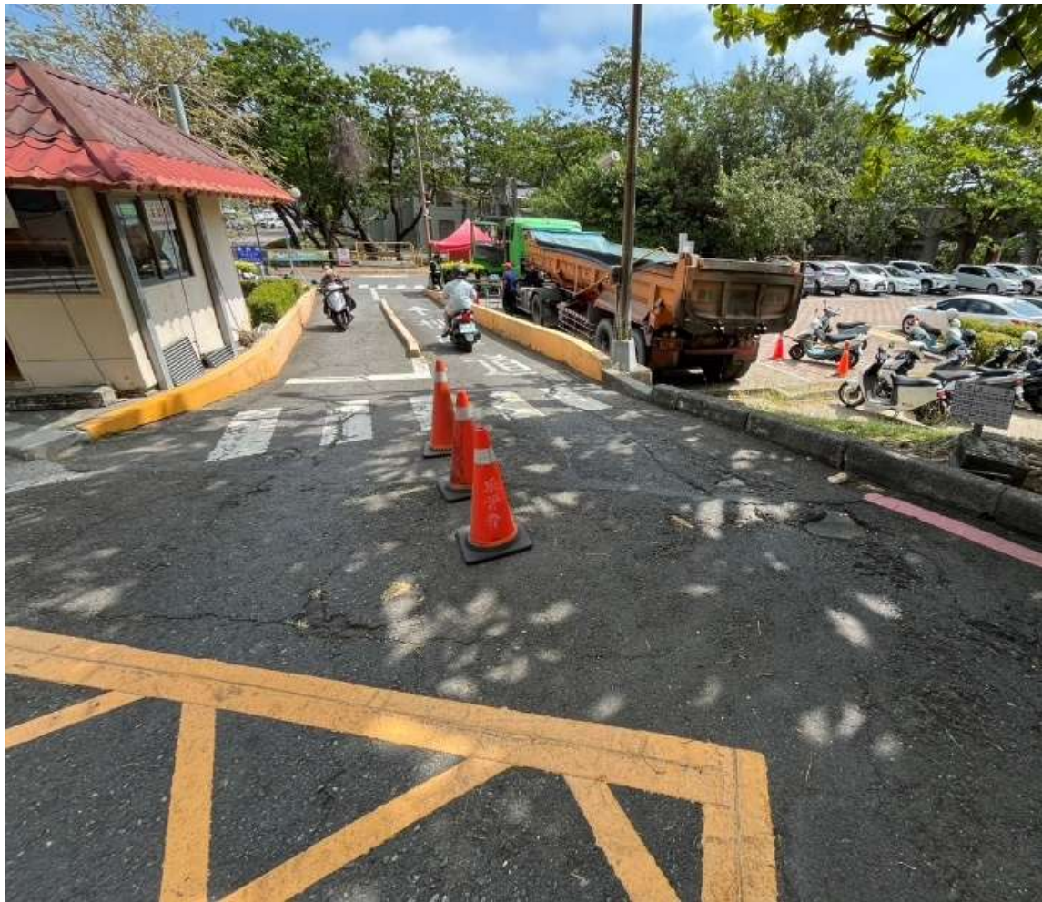
活動哨機車道路面刨鋪工程- 施工前
