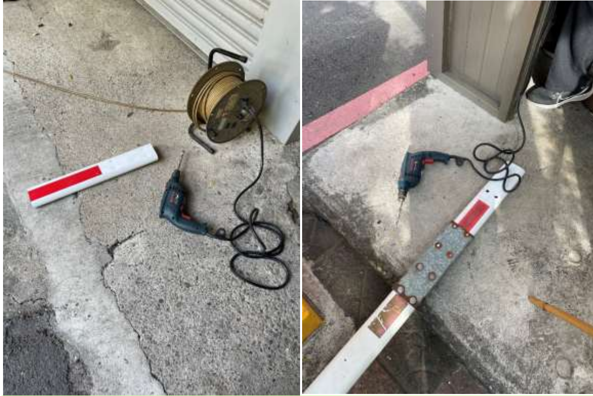
L柵欄機維修2次 施工前
