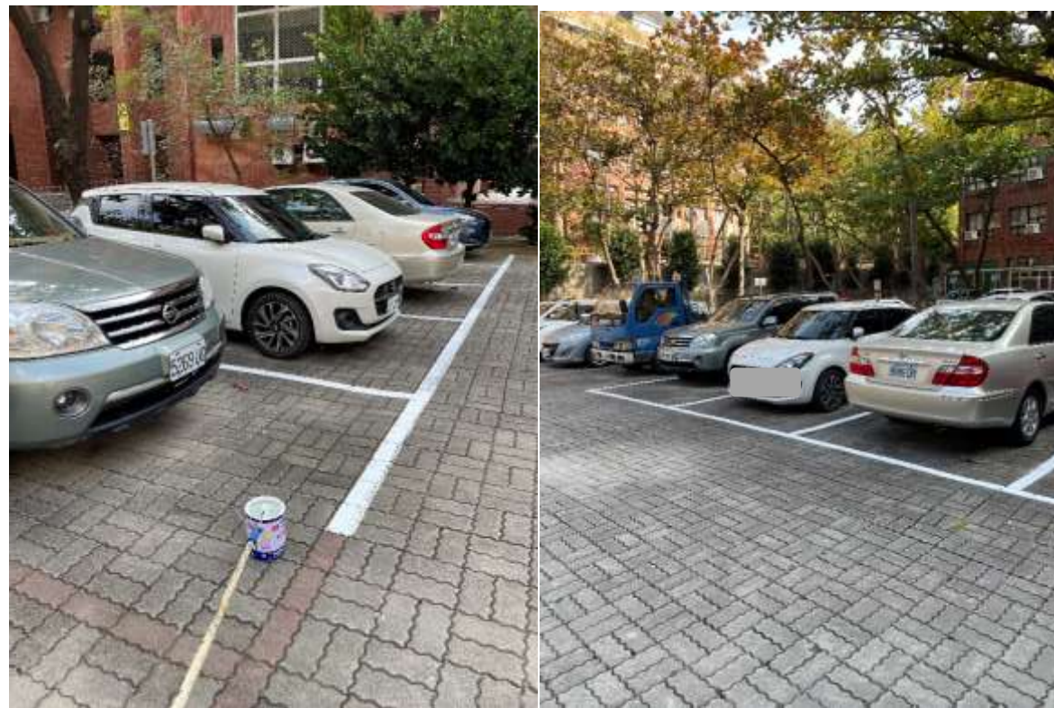
加強理工一道汽車格標線 施工後
