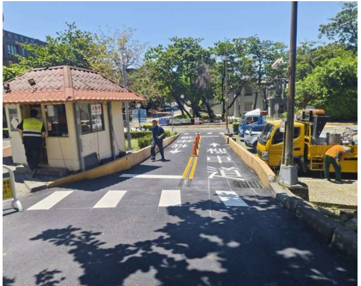
活動哨機車道路面刨鋪工程- 施工後
