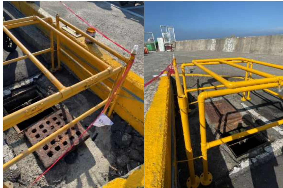
海堤停車場路口字鐵柵欄重新油漆 施工前 施工後
