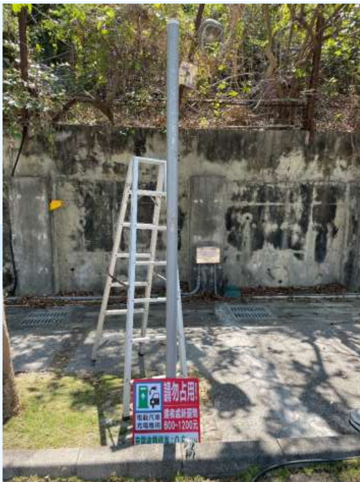
西子灣停車場更換充電樁牌面
