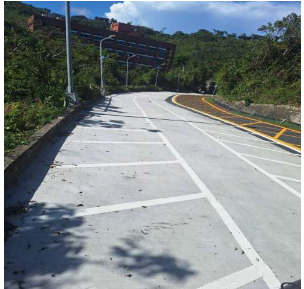
生態步道機車停車場 施工後
