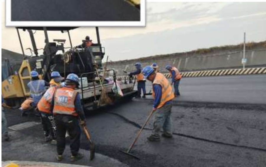
海堤停車場-施工後
