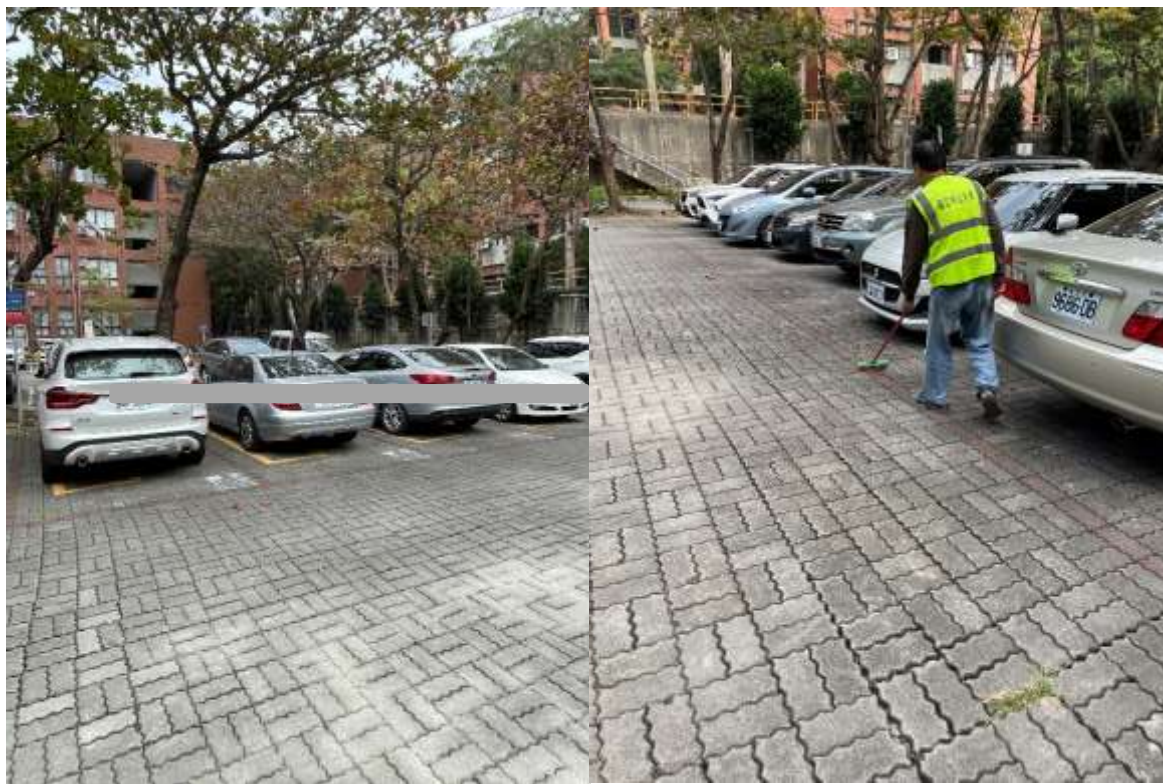
加強理工一道汽車格標線 施工前
