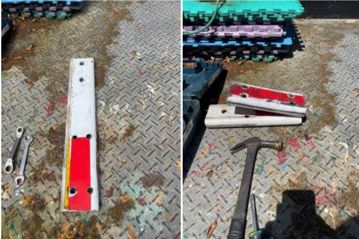
體育哨柵欄機維修2次 施工前
