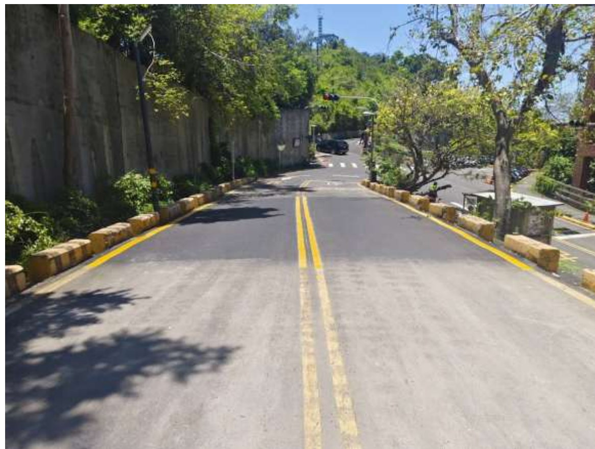
翠嶺道減速丘刨除 施工後
