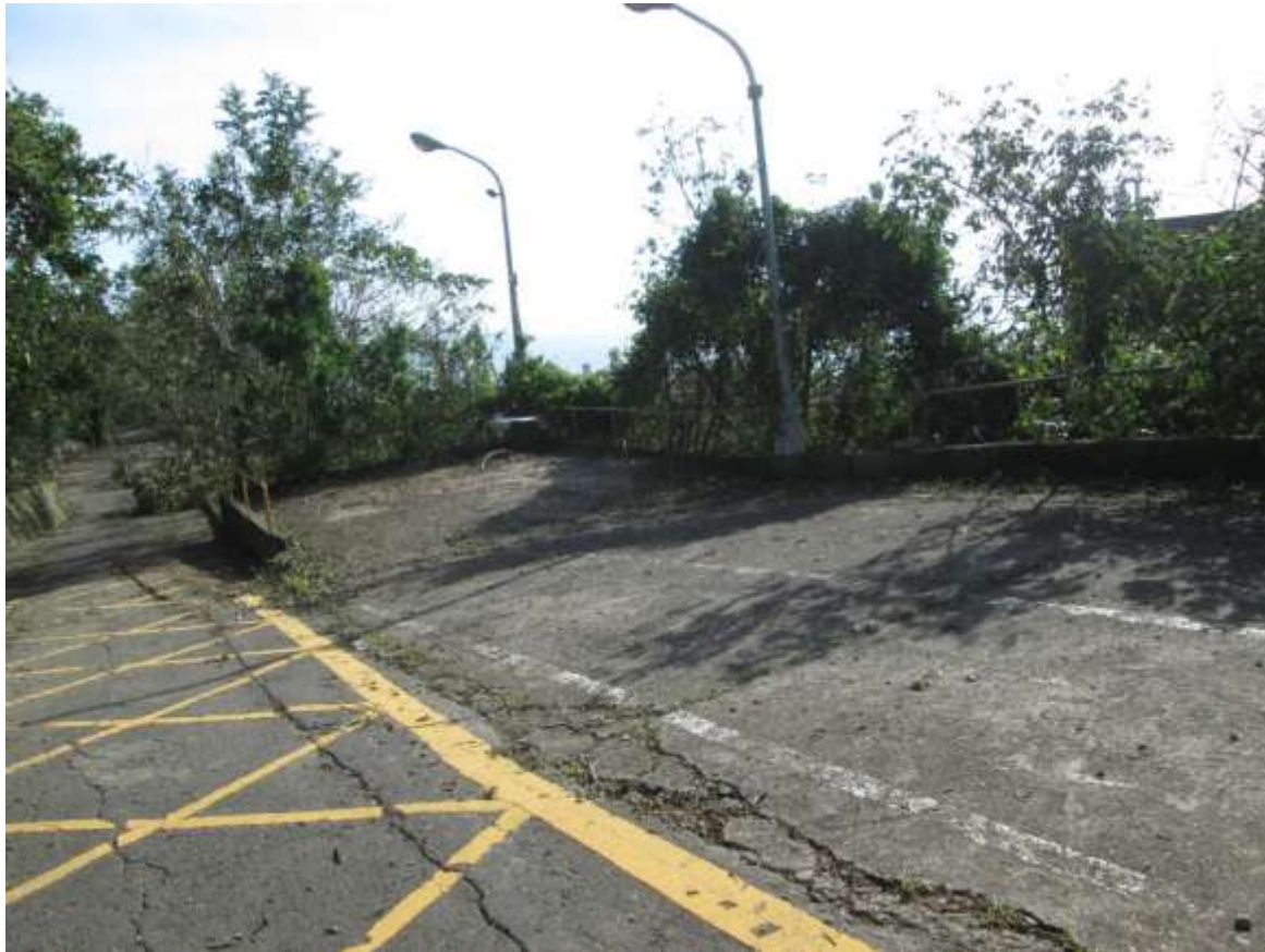
生態步道機車停車場 施工前
