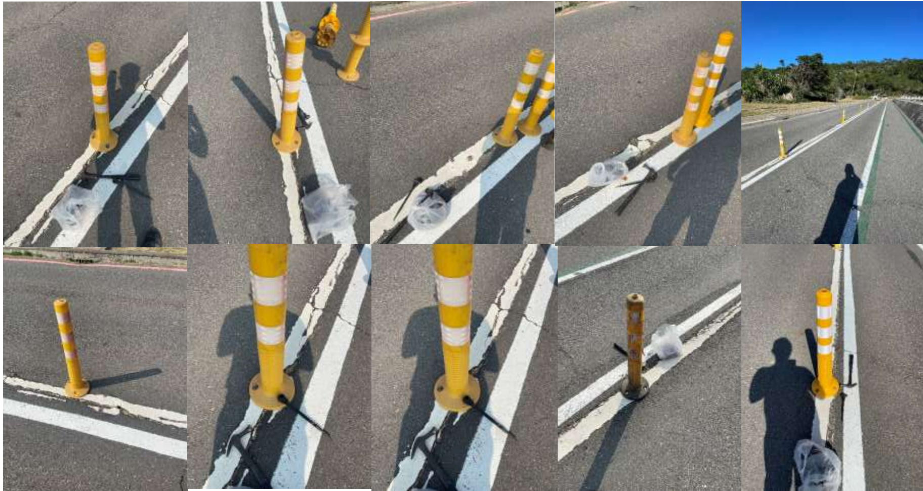
海堤停車場更換10支防撞桿
