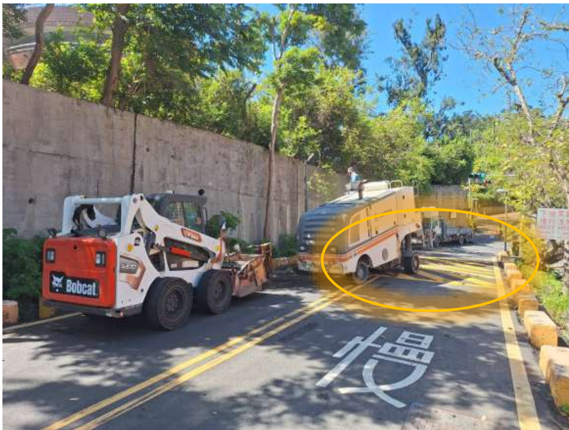
翠嶺道減速丘刨除 施工前
