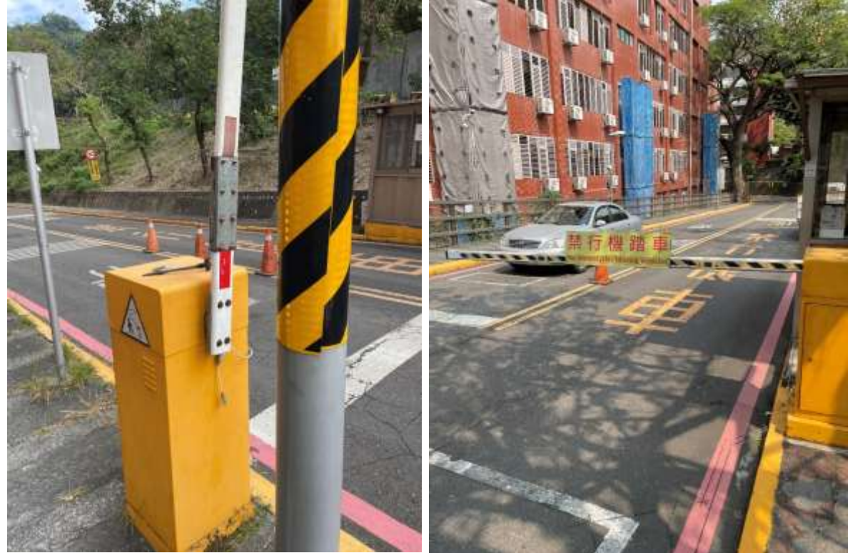
L柵欄機維修2次 施工後
