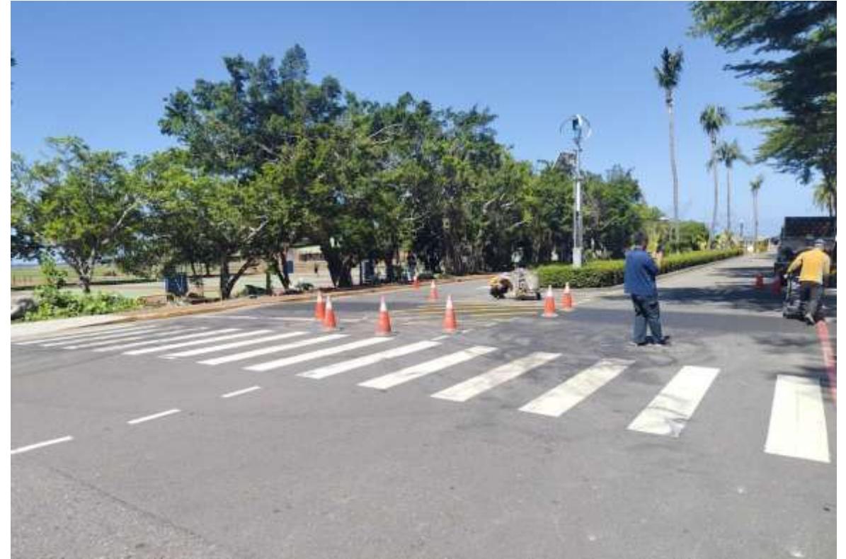
蓮海路 減速丘刨除 施工後
