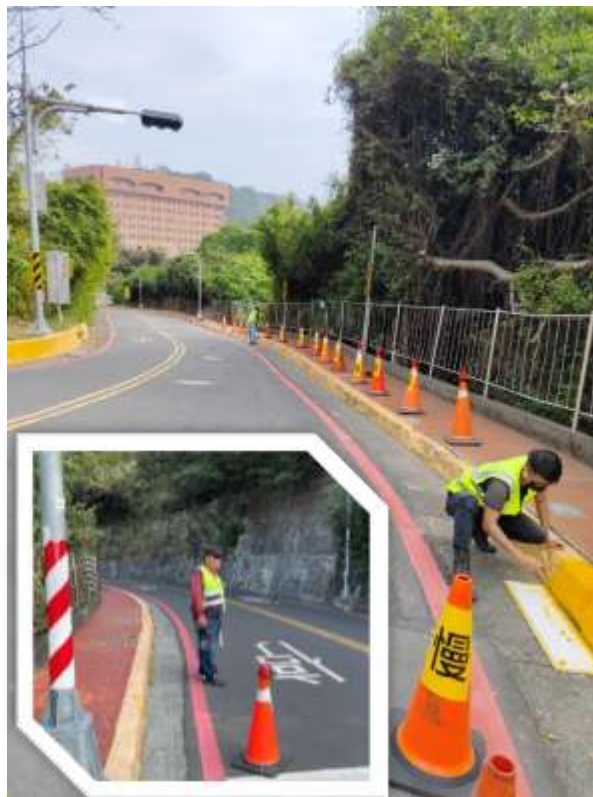
柴山大道路緣石重新油漆 施工前 施工後
