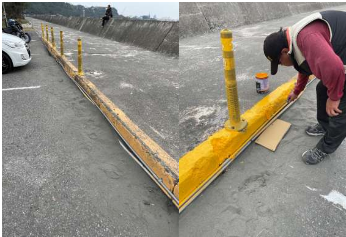
海堤停車場路緣石重新油漆 施工前 施工後
