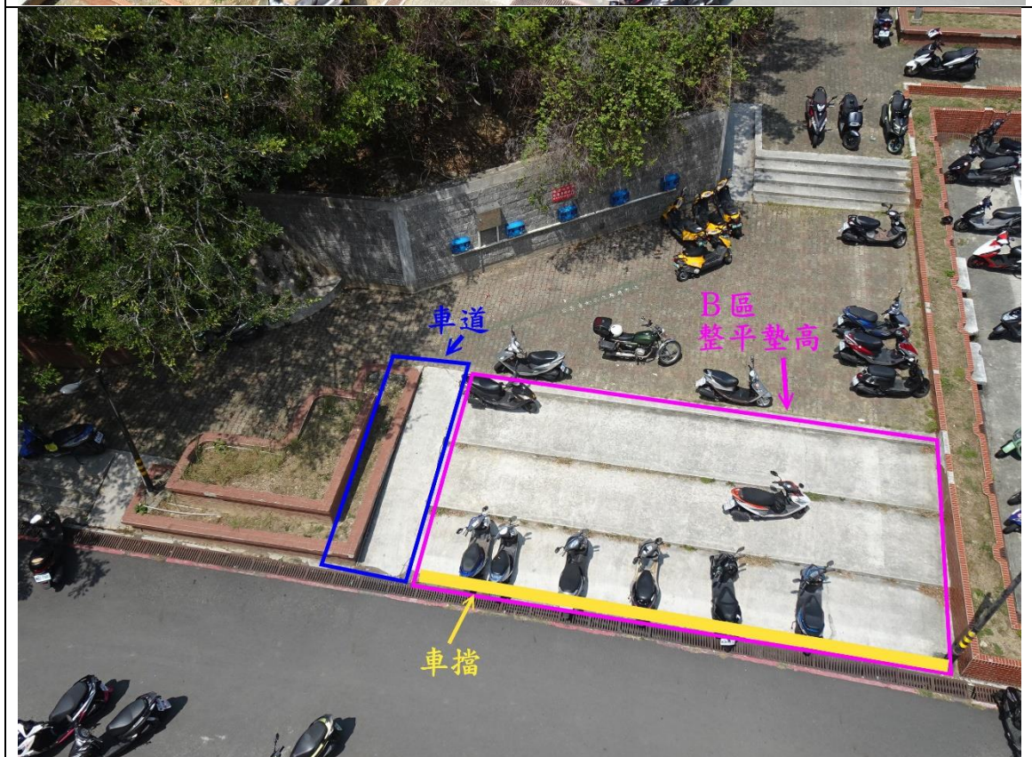
B 區： 整平墊高及設置車擋及花台修繕及拆除(上圖) 整平墊高及車道拓寬(下圖)
